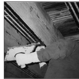
Les fentes ont ensuite été remplies d'une résine différente, l'époxyde Rotafix Resiwood CT10T Slow Set, et le tout a ensuite été raboté de façon affleurante à la surface inférieure du longeron.
