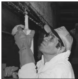
La base de chaque fente a été remplie de résine époxyde Rotafix Resiwood CB10T Slow Set.
