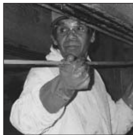
Une barre d'armature en PRF Rotaflex de 10 mm a été intégrée dans l'époxyde et maintenue en place à l'aide de broches à un mètre d'intervalle.
