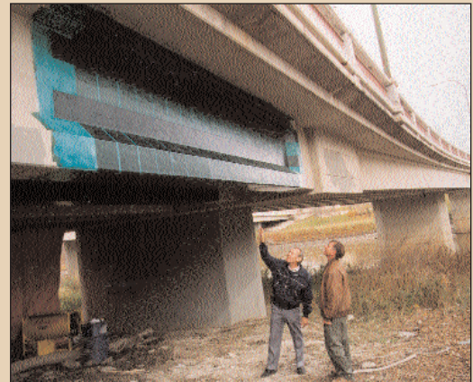
Ci-dessus : L'ingénieur municipal Gord Smith (à gauche) et Brad Neirmie inspectent la partie renforcée du pont Maryland.
