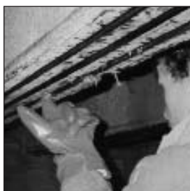
Des fentes (15 mm x 15 mm) ont été pratiquées à la partie inférieure de la poutre en utilisant une toupie industrielle.
