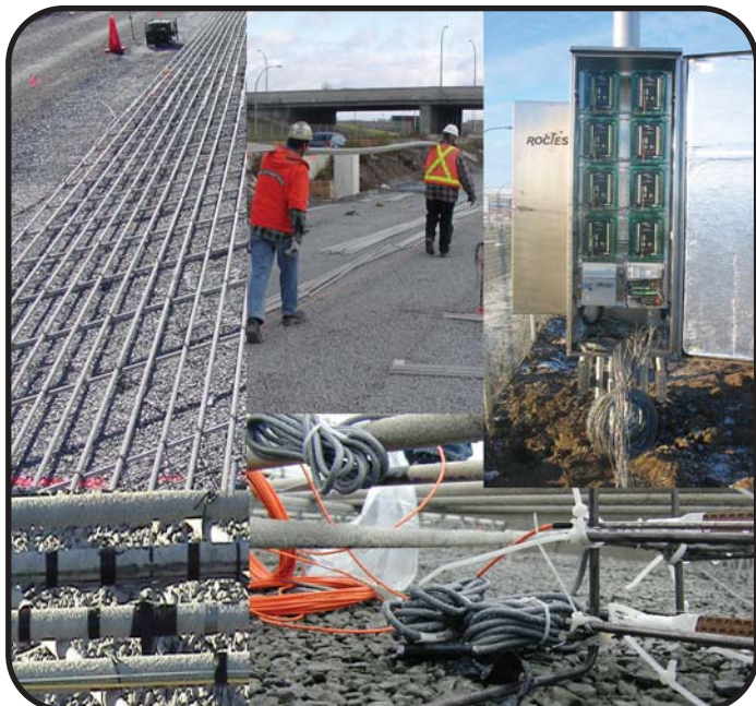
Photos de l'Autoroute 40, à Montréal, pendant la construction
