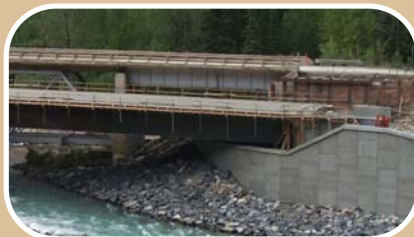
Pont de la rivière Trout, Autoroute de l'Alaska, C.-B
