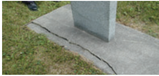
Fissure et détérioration d'une poutre de béton
